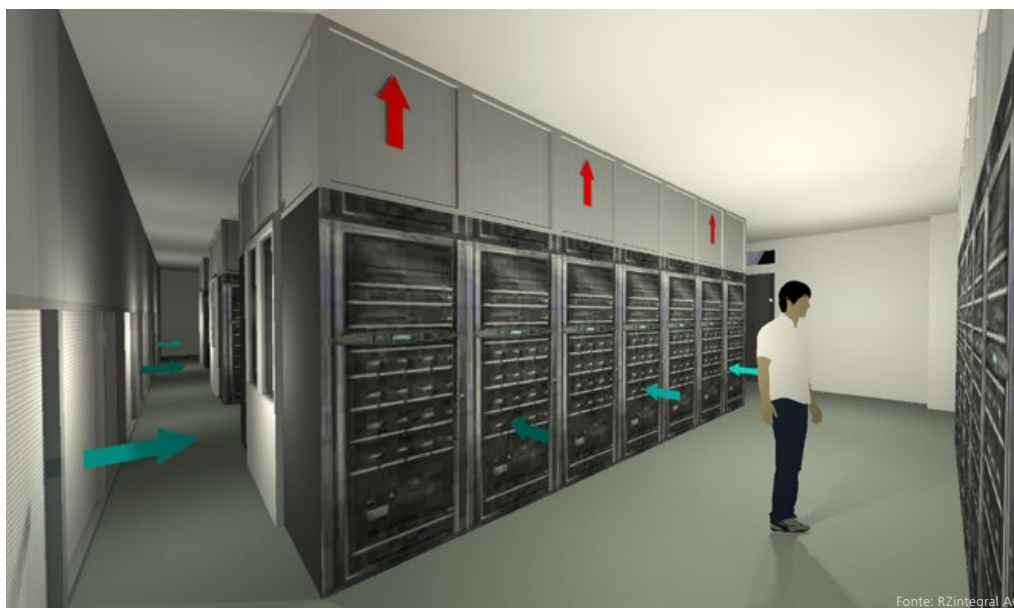
Immagine 2: schema alloggiamento corridoio aria calda
