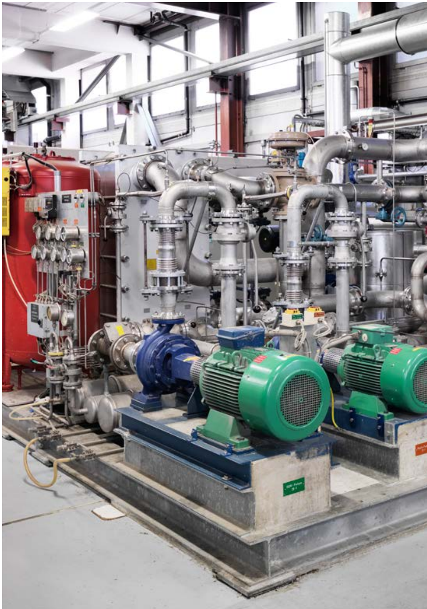
Elemento del circuito di raffreddamento che funge oggi da sorgente di calore.
